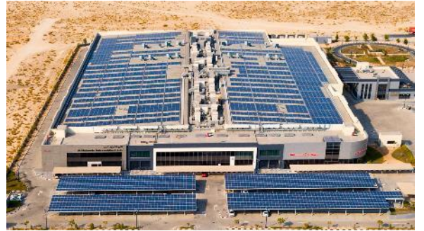
محطة الطاقة الشمسية المثبتة على مرآب السيارات وورشة الدهان والهيكلمبنى الاختبارات في النابودة للسيارات في مدينة دبي الصناعية
